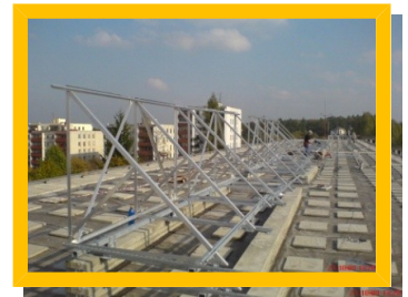
Montáž 45° konstrukce pro kolektory.
