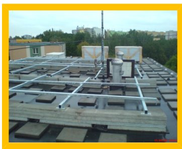
Montáž PZD desek nosné konstrukce.
