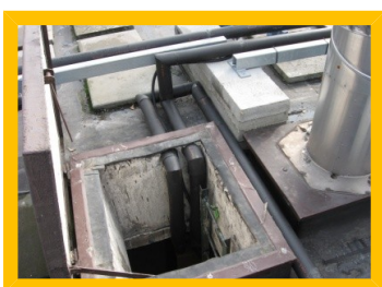
Vstup vedení do objektu.
