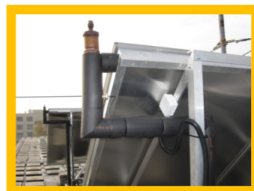
Detail napojení odvzdušnění a teplotního čidla kolektoru.
