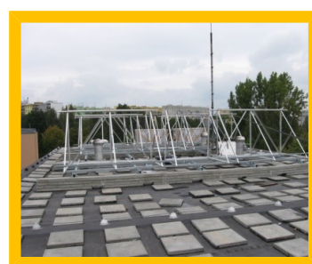
Montáž 45° konstrukce pro kolektory.
