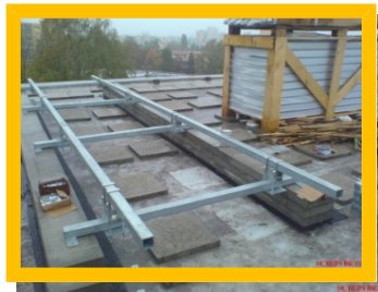
Montáž nosné konstrukce.
