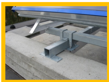
Detail uchycení nosné konstrukce.
